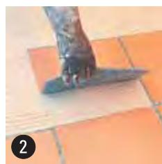
Colocar los paneles VITROGRES sobre el cemento cola.
