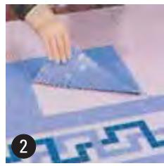
La colocación de los paneles sobre el cemento cola es ahora más fácil gracias a la lámina transparente.
