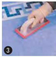
Golpear el revestimiento con una llana de madera o goma, con el fin de que penetre en la capa de cemento cola.
