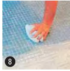
Una vez seco, limpiar el revestimiento con un trapo seco.
