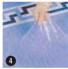
Quitar la lámina que recubre los paneles VITROGRES como se indica en la foto. El revestimiento quedará prácticamente limpio, sin necesidad de limpiar el adhesivo como en el sistema de pegado con papel, reduciendo el tiempo de colocación.
