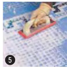
Rellenar las juntas con una llana y cemento especial para juntas, acelerando la colocación al no tener que quitar el adhesivo como en el sistema de pegado con papel.
