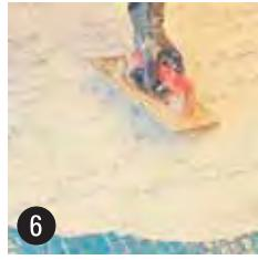
Rellenar las juntas con una llana y cemento especial para juntas.
