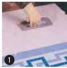
Extender con una llana dentada una capa de cemento cola de 2 a 3 mm. de espesor.
